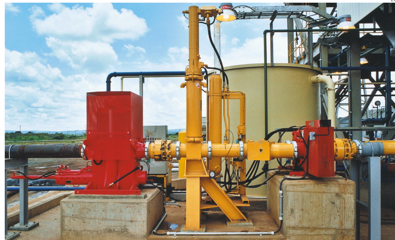
Molchweiche ZX 200, Hochdruck-Dämpfungskessel HPD 200/750 und Rohrweiche DVH 412
